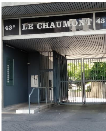
Plan incliné pour accès piétons et PMR depuis la rue d'Hautpoul
