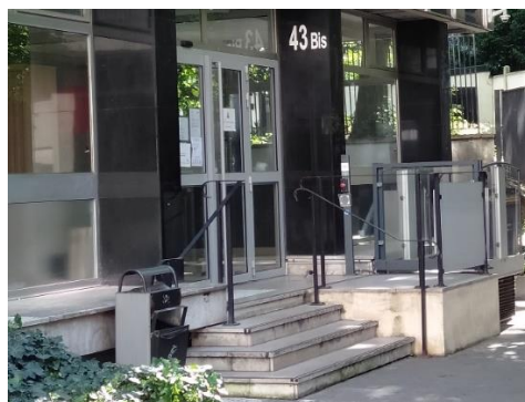
Escalier avec rampe et bandes adhésives antidérapantes
